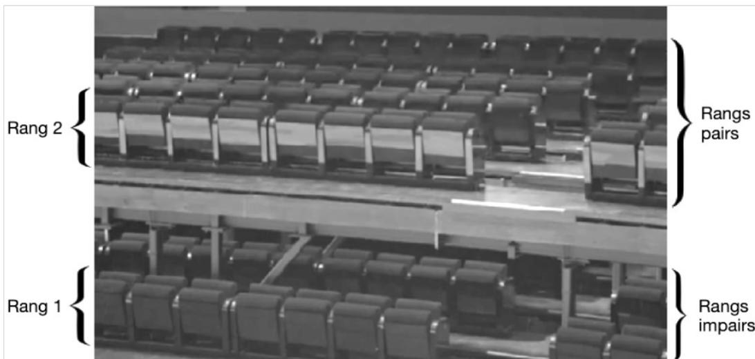
Figure 15 – Changement de configuration du parterre : fin de la procédure
